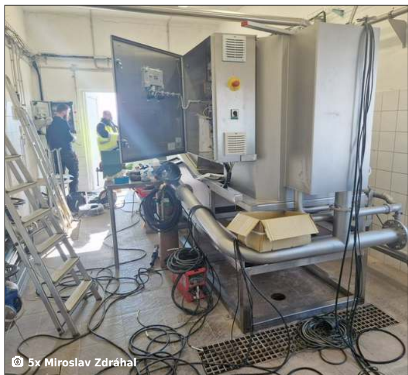
Instalování nové kalové koncovky na ČOV Velký Týnec
