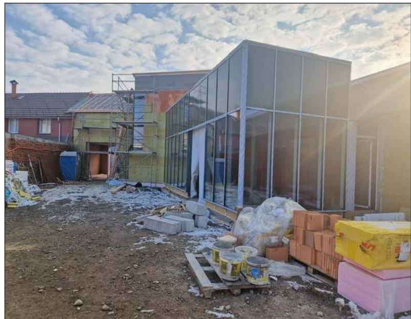
Výstavba komunitního centra Velký Týnec vstupuje do závěrečné fáze
