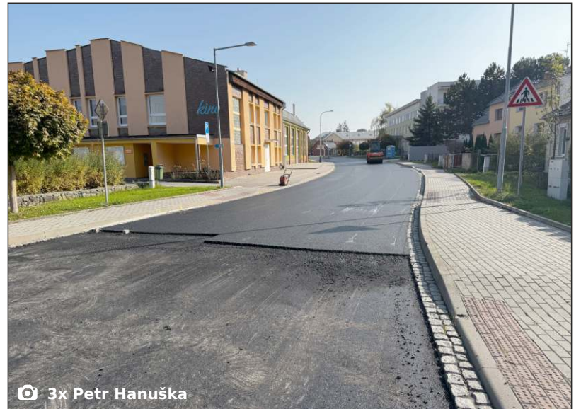
Dokončení oprav povrchů krajských komunikací ve Velkém Týnci...
