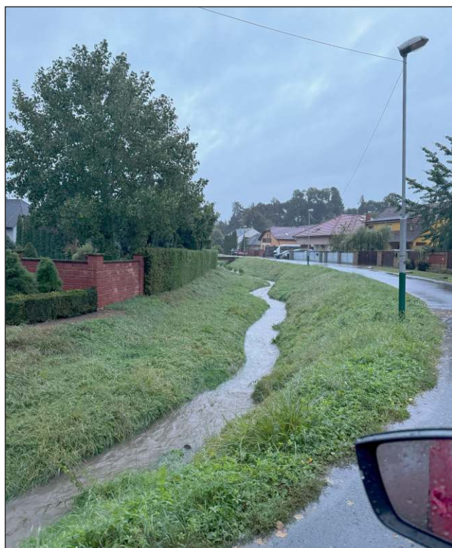
Koryto Týnečky v Zápotočí to zvládlo, ale nutně potřebuje vyčistit
