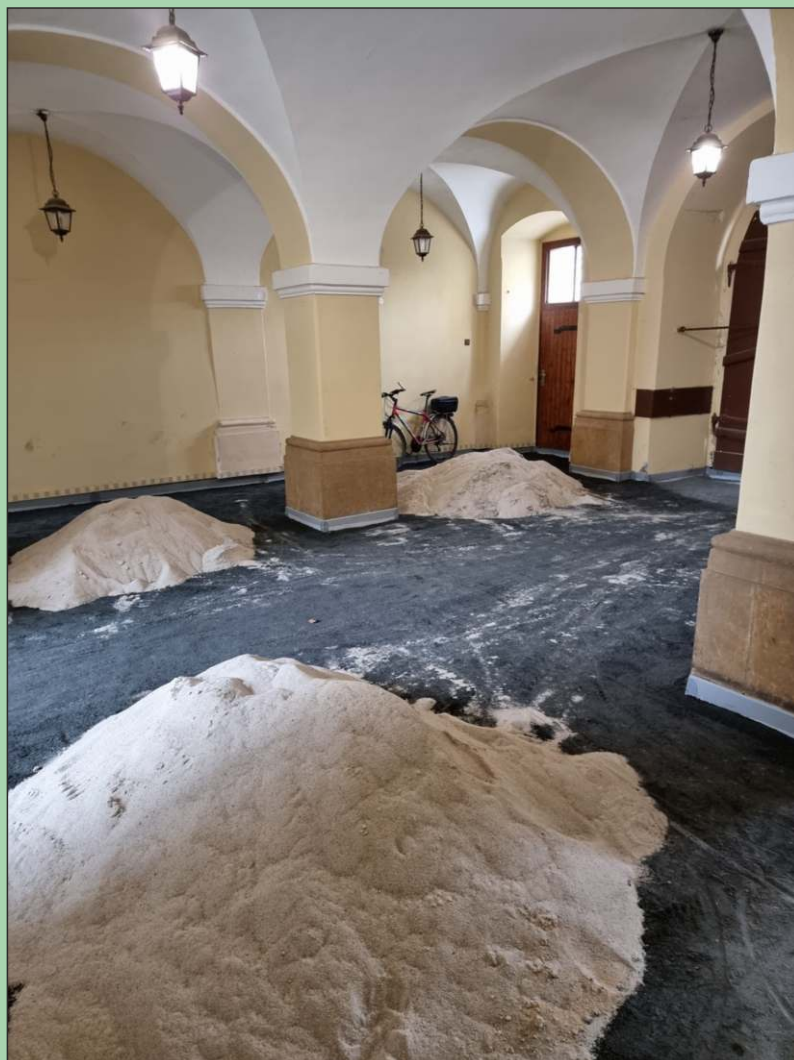
Položení nové podlahy v zámecké chodbě
