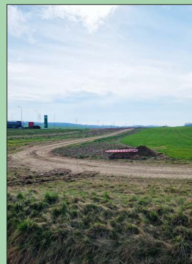
Pomalou se rozběhla stavba dálnice Olomouc-Kokory
