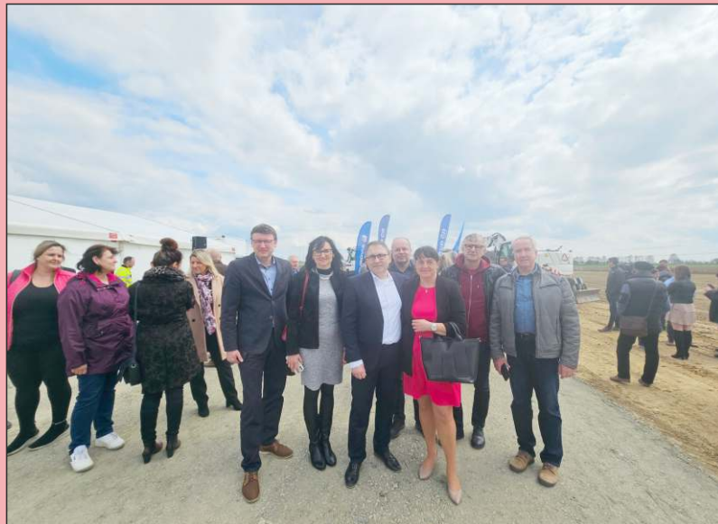
Stavba dálničního úseku Olomouc-Kokory byla slavnostně zahájena i za přítomnosti starostů okolních obcí
