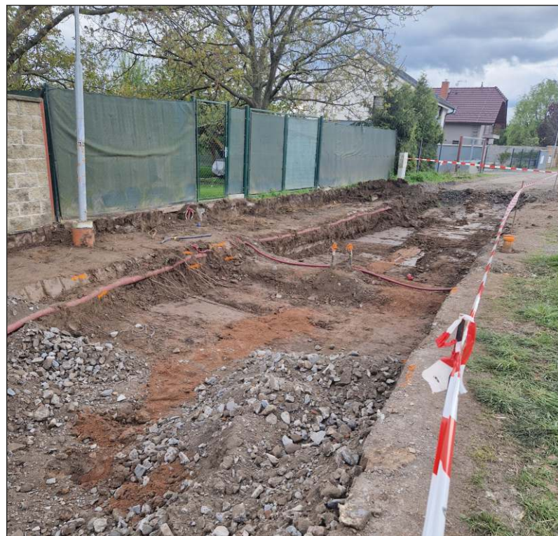
Výstavba nové komunikace a chodníku v Sadové ulici
