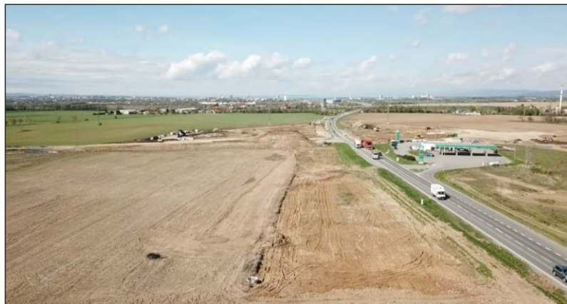
Stavba mimoúrovňové křižovatky mezi Velkým Týncem a Grygovem
