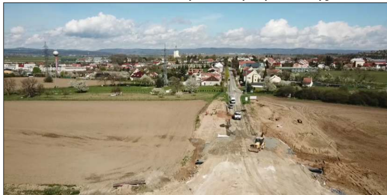
Od Velkého Týnce se začíná rýsovat násyp nového mostu...
