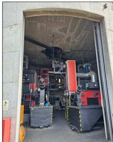
Zařízení na výrobu odpadního tepla v areálu firmy Hon v obci Skřípov. Pohled na dva kotle, kde probíhá spalování nadrceného výrobního odpadu, který je ke kotlům dopraven šnekovým dopravníkem ze skladovacího síla umístěného nad prostorem kotelný
