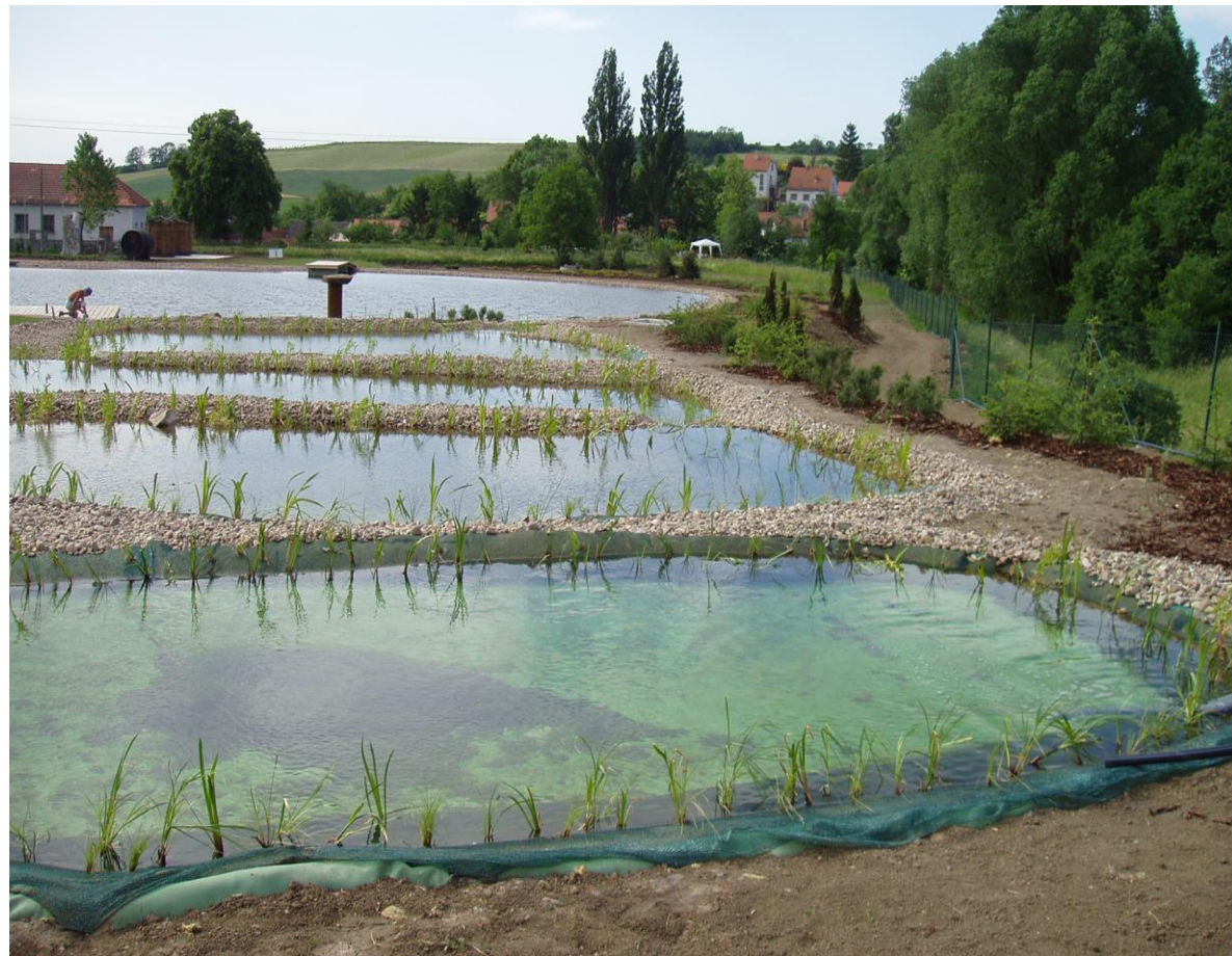
Pohled na biotop přes filtrační laguny, květen 2007 bezprostředně po dokončení
